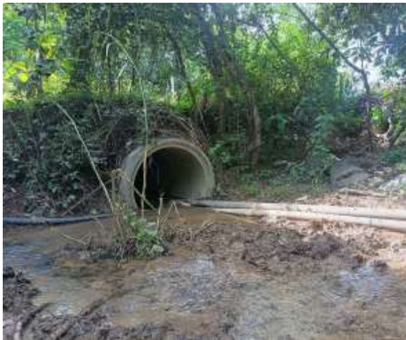
รูปที่ 2-32 วางท่อระบายน้ำลอดด้วยท่อคอนกรีตเสริมเหล็ก ห้วยแม่ยาก (ภาพกิจกรรมล่าสุด)
